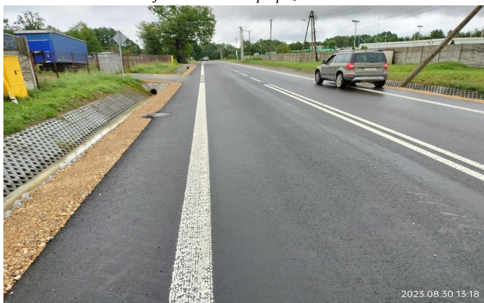
Zdj.40. DP 1023 S po przebudowie
