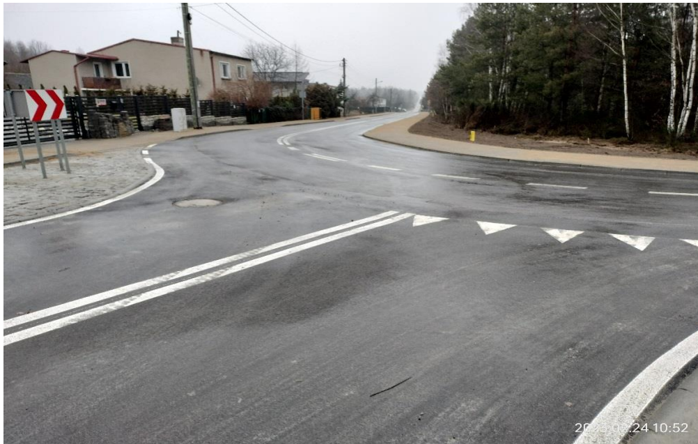
Zdj.37. DP 1051 po przebudowie
