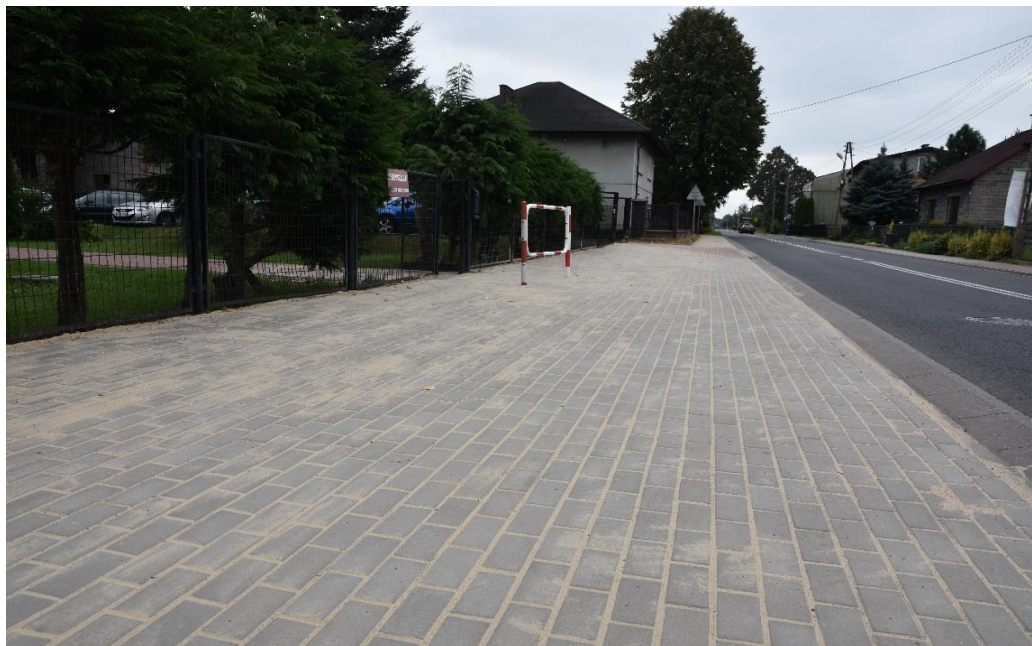
Zdj.43. DP 1025 S Utwardzenie pobocza
