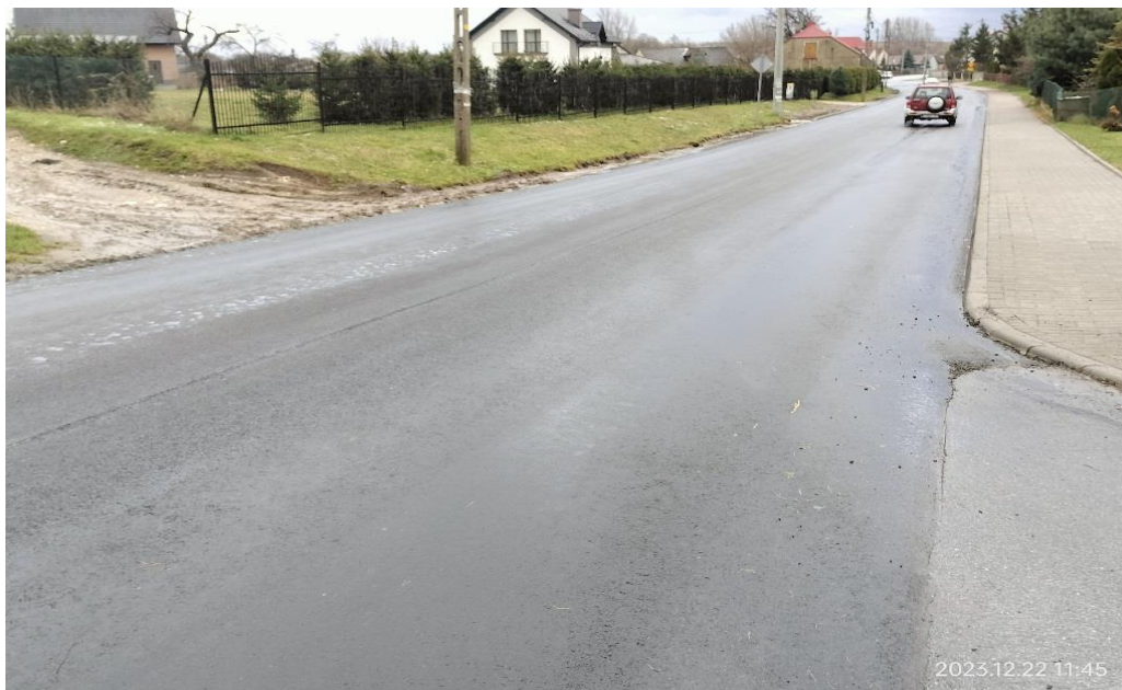
Zdj.42. DP 1038 S po przebudowie
