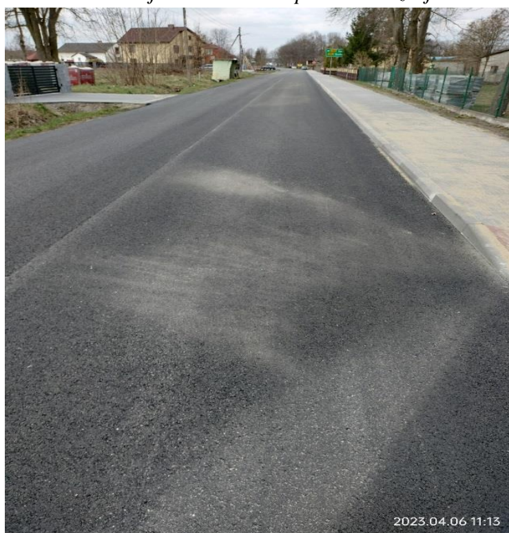
Zdj.46. DP 1081 S po modernizacji
