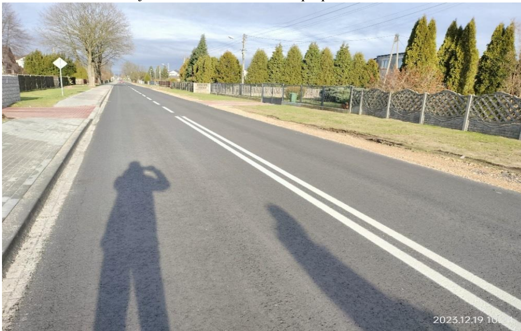
Zdj.34.DP 1024 S i 1028 S po przebudowie
