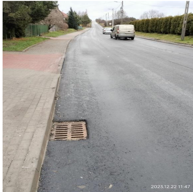
Zdj.41. DP 1038 S po przebudowie
