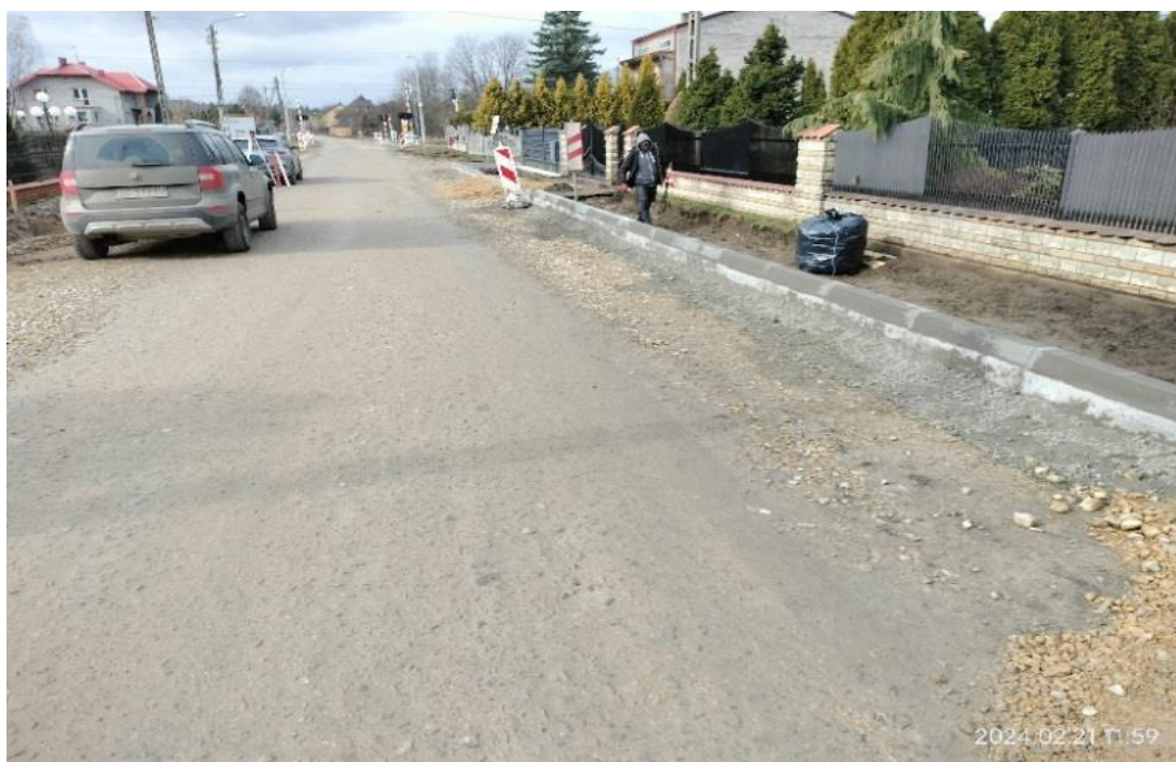
Zdj.29. DP 1072, Stary Broniszew, gm. Mykanów droga w trakcie przebudowy
