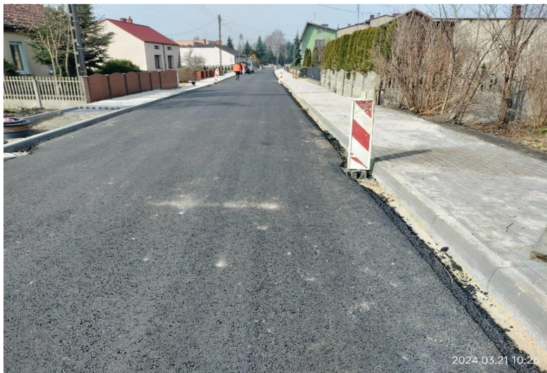
Zdj.30. DP 1072, Stary Broniszew, gm. Mykanów droga w trakcie przebudowy
