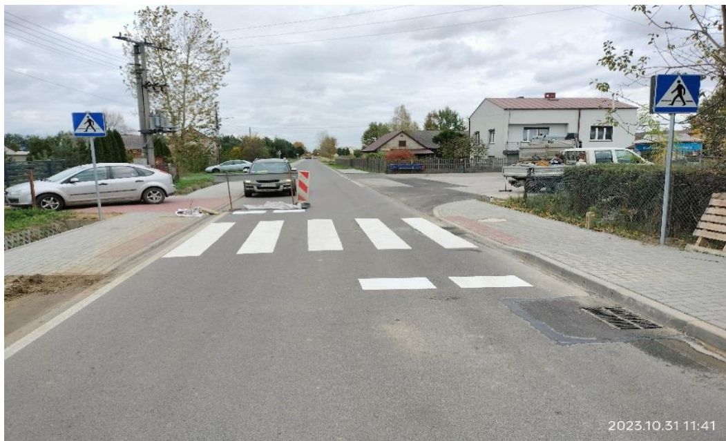
Zdj.35.DP 1077 po przebudowie
