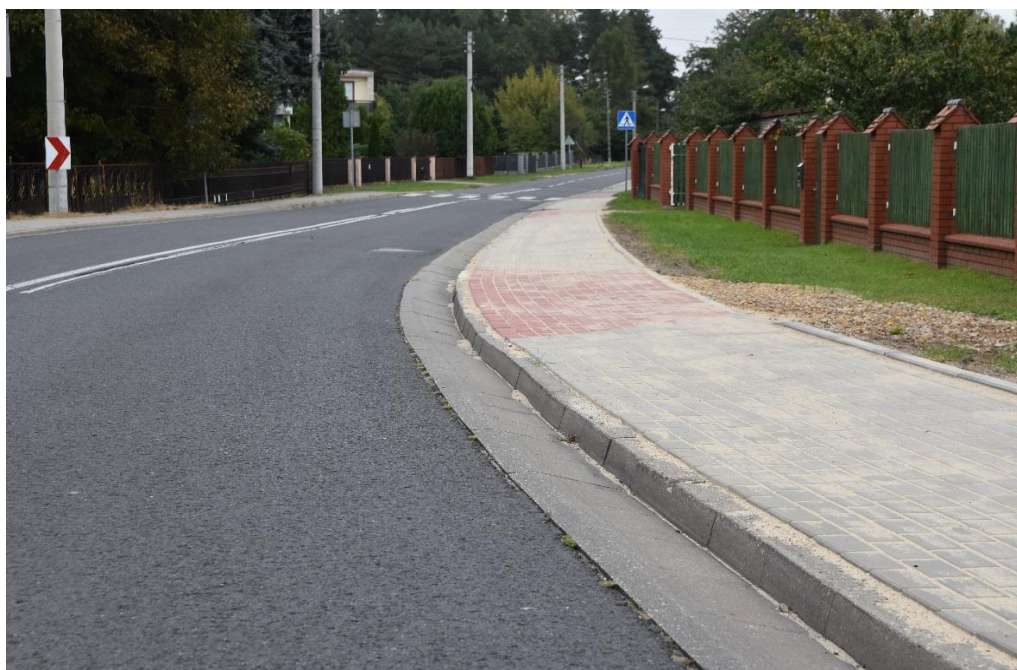
Zdj.44. DP 1025 S Utwardzenie pobocza
