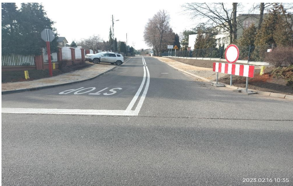
Zdj38. DP 1051 po przebudowie
