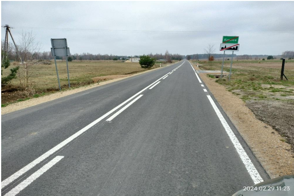
Zdj.33. DP 1024 S i 1028 S po przebudowie
