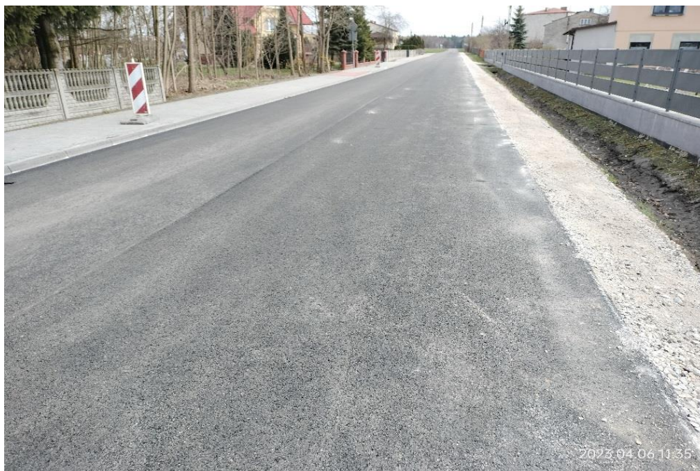
Zdj.45. DP 1081 S po modernizacji
