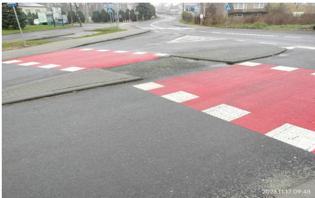
Zdj.31. DP 1059S Mykanów-węzeł autostradowy, gm. Mykanów po przebudowie
