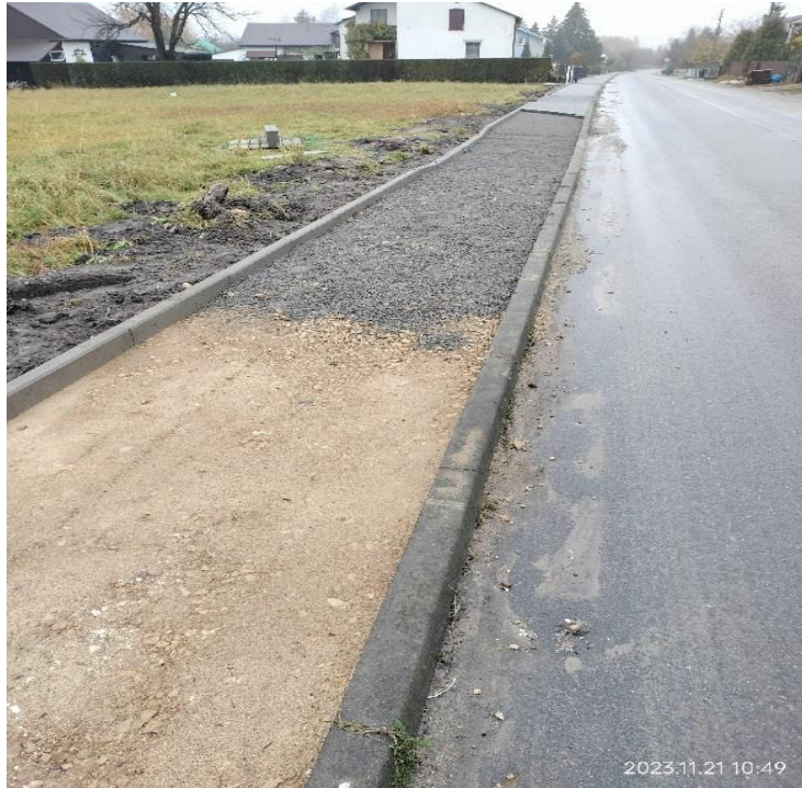
Zdj.47. DP 1087 S w trakcie przebudowy
