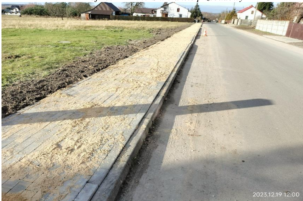
Zdj.48. DP 1087 S po przebudowie
